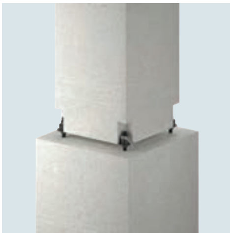
圖4: 用合適的扳手擰緊上下螺帽
